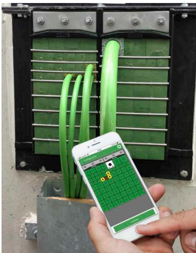
Progettata per essere usata su dispositivi mobili iOS o Android (smartphone o tablet), la App permette agli installatori di calcolare automaticamente la configurazione migliore del passaggio e di esportare la lista di materiali, il disegno con i codici colore e altre informazioni importanti.
