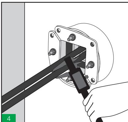
4 Medir el diámetro de los cables y seleccionar el taco HTS con el rango apropiado. El código de color ayudara a seleccionar el taco correcto.
