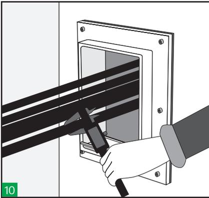
10 Messen Sie die Kabeldurchmesser und wählen Sie die geeigneten Hawke-Toleranzmodule aus. Der Farbcode unterstützt Sie bei der Auswahl der passenden Module. Verwenden Sie nur schwarze H-DM-Module.
