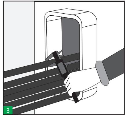
Messen Sie die Kabeldurchmesser und wählen Sie die geeigneten Hawke-Toleranzmodule aus. Der Farbcode unterstützt Sie bei der Auswahl der passenden Module.
