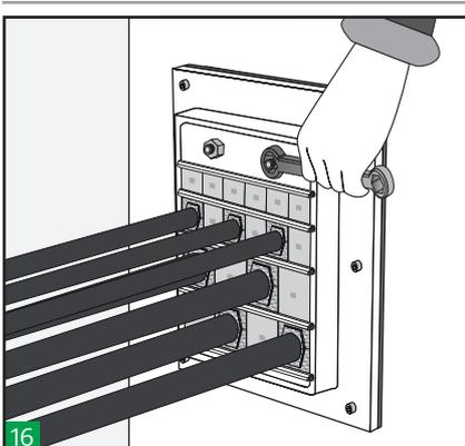
16 Ziehen Sie die Muttern an der Endabdichtung abwechselnd an, um die Dichtung zusammenzupressen und damit die vollständige Dichtheit sicherzustellen.
